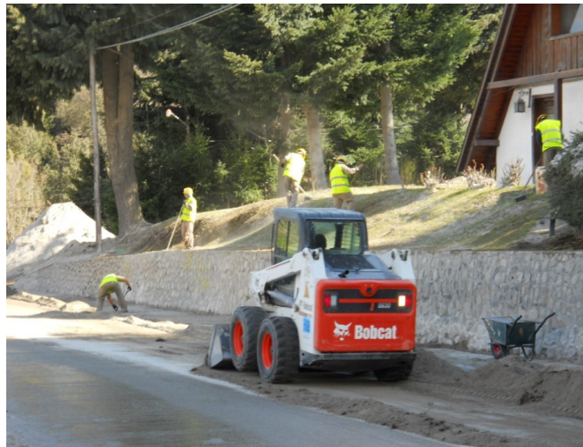
Trabajos de las cuadrillas.
