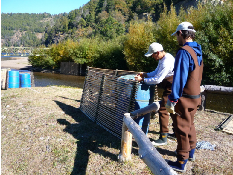
Armado de la barrera para peces de caña Colihue. Arroyo Pocahullo – Lago Lacar.
