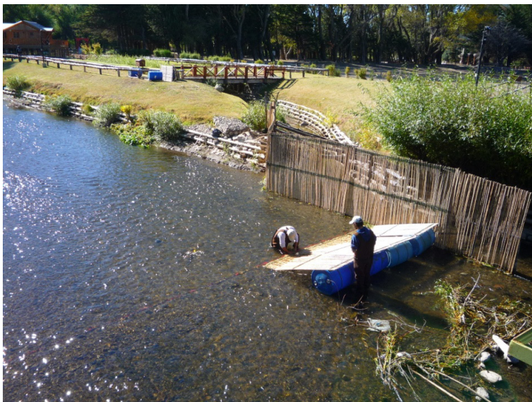
Colocación de la barrera para peces. Arroyo Pocahullo – Lago Lacar.
