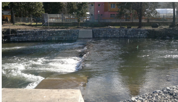
Dique peine selectivo. Arroyo Pocahullo. San Martín de los Andes.
